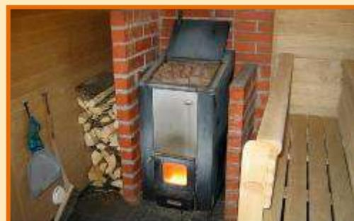
Важнейшей мерой, направленной на снижение пожароопасности бани, является перекрытие потока тепла, идущего от печи к деревянной стене. Это можно обеспечить при помощи укладки слоя негорючего покрытия либо установки негорючих экранов, размещаемых между стеной и печью. Наиболее подходящий вариант — система из двух экранов, отводящих тепло за счет конвекции воздуха.
